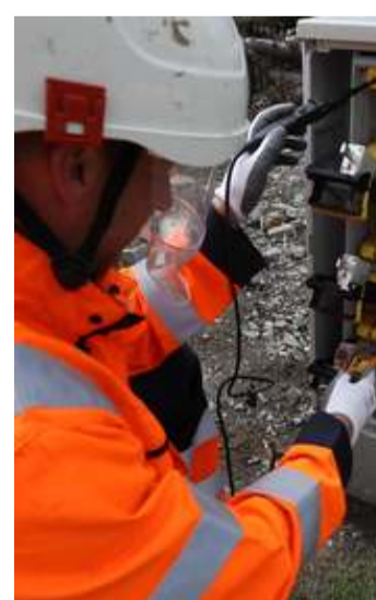
Le chantier va durer 3 à 4 jours. © RESA
